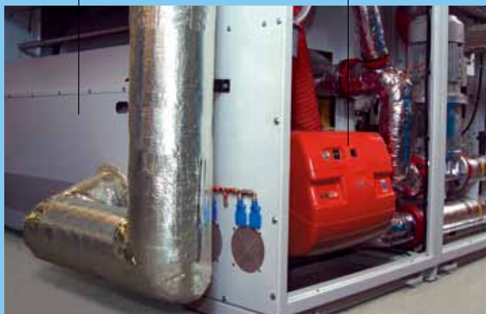
一体化されたガス燃焼室と熱交換器
