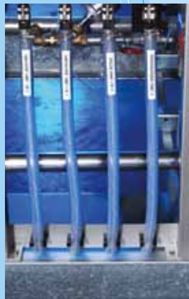
ホースの取出し
